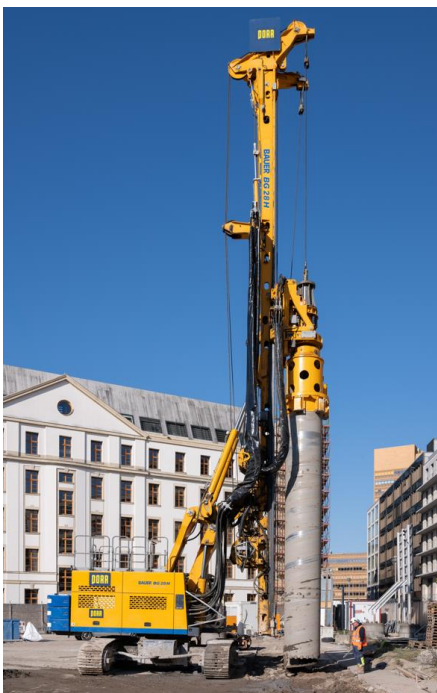
5.240 m 2 Schlitzwände und 900 Meter Gründungspfähle sichern die Baugruben für den zukunftsweisenden Ministeriumsneubau. © PORR
